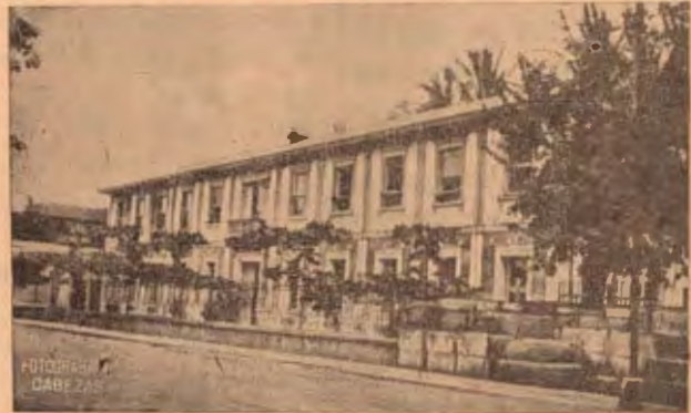
Antigua Escuela Antonio Gámez, de varones, se construyó en la primera Administración de don Cleto por la casa Fabián y C o de San José y los trabajos los dirigió don Fernando Grüter. En la Administración de don León Cortés se botó por estar en mal estado, bajo la promesa de su pronta construcción, pero todavía estamos esperando.
